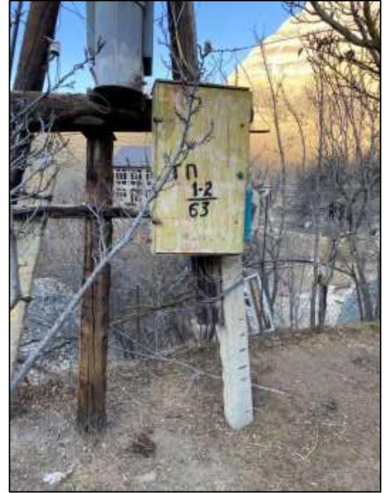
По результатам осмотра ВЛ 0,4 кВ Ф-1 МТП-1-2/63 была выявлена однофазная перемычка между проводом ВЛ 0,4 кВ Ф-1 КТП-1-1/400 и проводом ВЛ 0,4 кВ Ф-1 МТП-1-2 ВЛ-10 кВ Ф-1 ПС 35 кВ Карата, что послужило способом подачи напряжения 0,4 кВ на трансформатор МТП-1-2/63 и обратную трансформацию напряжения уровня 10 кВ на шпильки вводов трансформатора.
